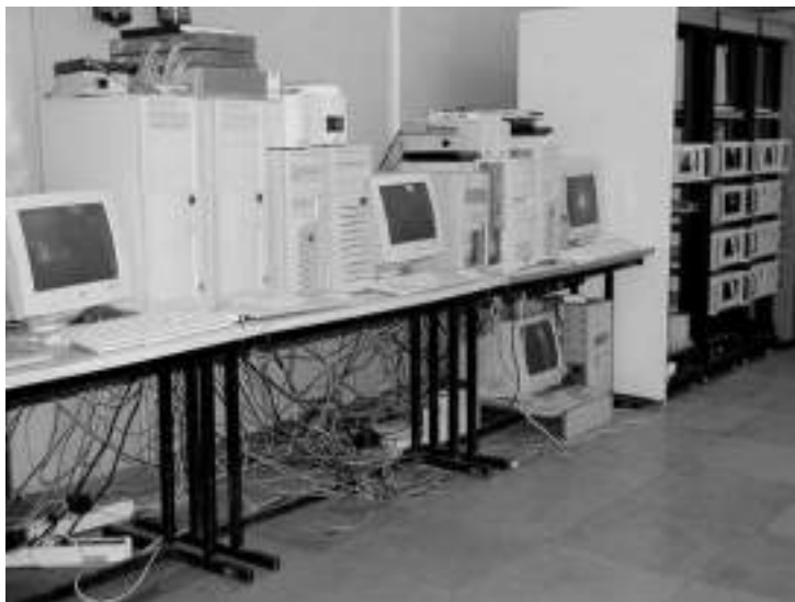
Оборудование сети Механико- математического факультета МГУ.
