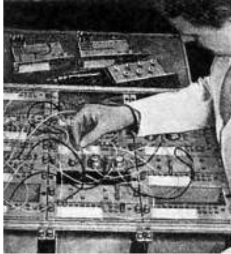
Установка новой задачи на коммутационной панели машины фирмы «Элиот».
